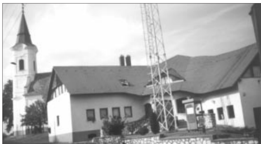
Das Gemeinschaftshaus in Koppan
